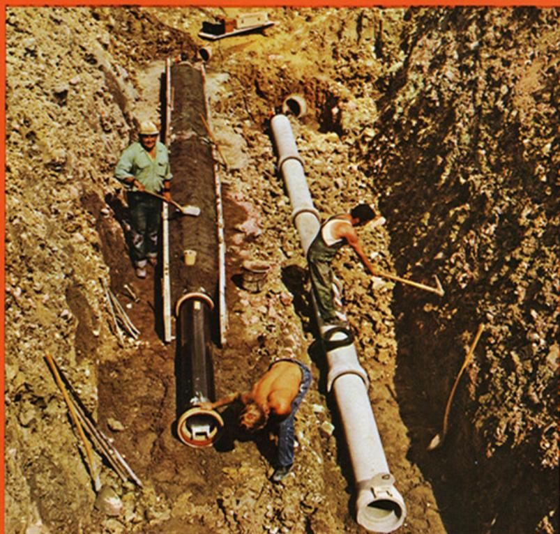
Nach dem Verlegen des zweiten Rohres kann das Gerät ins Rohrende gesetzt werden und bietet alle Voraussetzungen für eine exakte Rohrverlegung.
